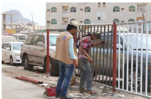
Construction d'une barrière en métal devant le portail de l'école, en février 2019. Photo de l'association Al-Aidroos.
