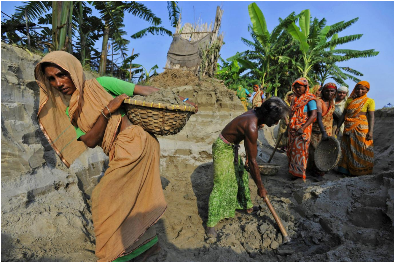
Sufia, aidée de journalières, participe à la surélévation du sol en dessous sa maison, face à la hausse du niveau de la mer et aux fortes marées. Char Atra, district de Shariatpur, Bangladesh (2009). © Dan Chung/Oxfam GB
