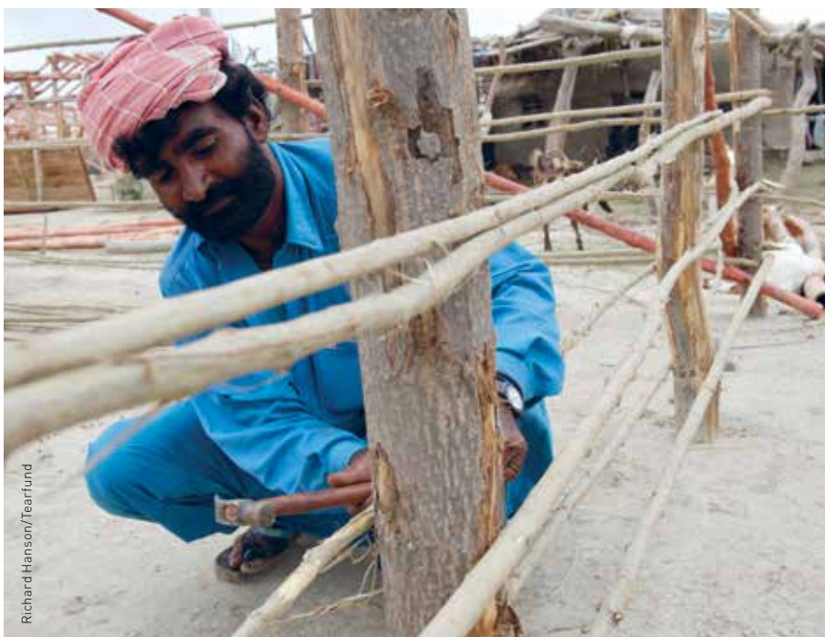
Building new houses at Saleh Jath village, with support from Tearfund, following the 2010 Construction de nouvelles maisons au village de Saleh Jath avec l'aide de Tearfund, suite aux inondations de 2010 au Pakistan.
