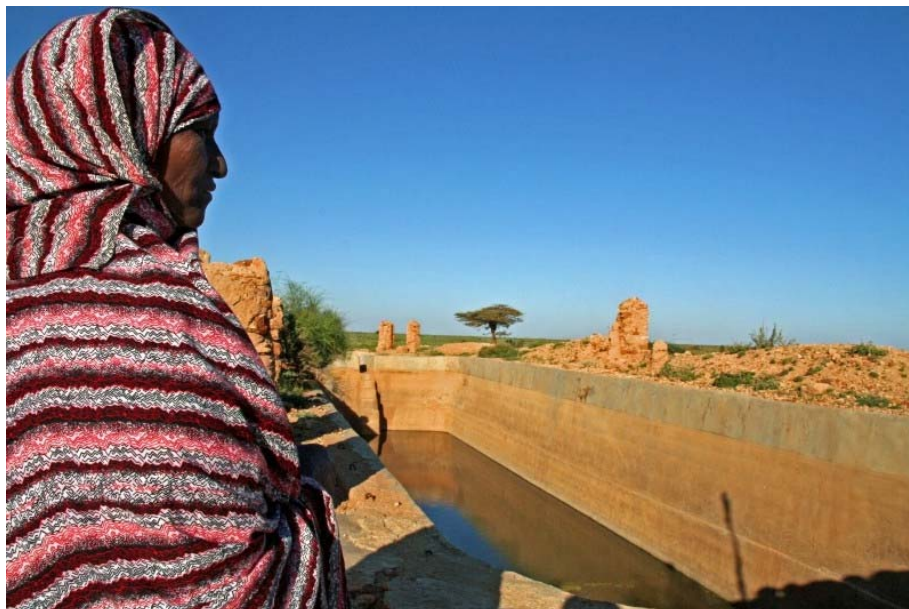
Sarahaa Malmud Muhumed à côté d'un birkhad construit par Oxfam, un bassin protégé collectant les eaux de pluie et utilisé lors de la longue saison sèche, Harshin, région Somali. Photo : Oxfam/Maite Alvarez
